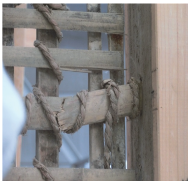
写真4 間渡し竹の折損(存置)
