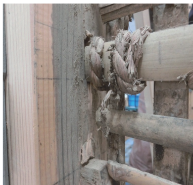
写真3 拡大した間渡し穴(存置)
