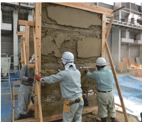
写真1 剥離部分の除去
