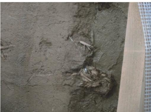
写真4 横縄の又釘による留め付け
