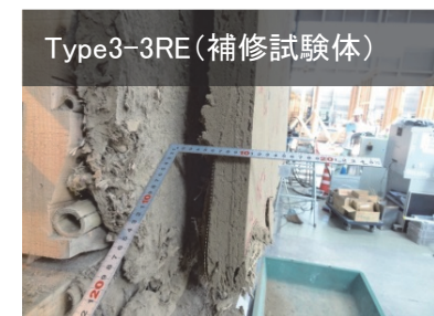
写真1 壁土のはらみ出し (1/7rad)
