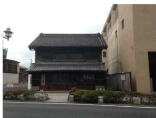
写真5 改修前建物外観
