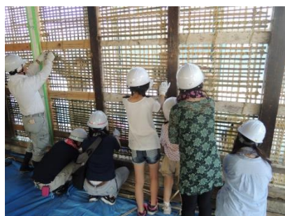
写真6 伝統建築の修理
