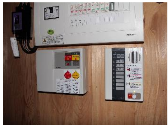
写真4 火災感知システムの導入(高山市下二之町大新町)
