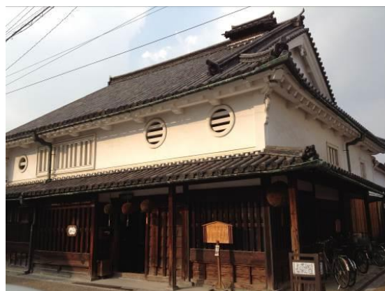
写真10 虫籠窓・軒裏の塗込め①(檀原市今井町)
