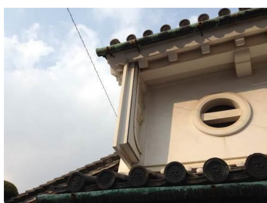
写真12 袖壁(檀原市今井町)
