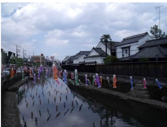
写真7 河川沿いの土蔵群(栃木町)
