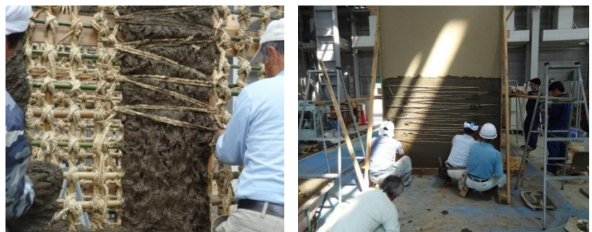
写真3 ①荒打ちの柱周りの縄(かがり縄)
