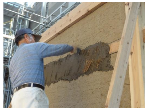
写真1 横貫の貫伏せ
