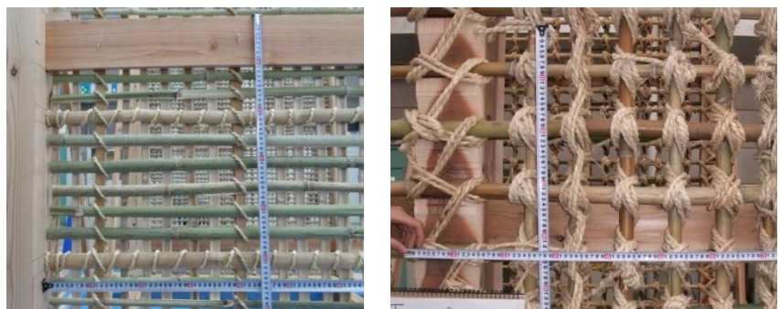
写真2 小舞下地の形状(左:住宅向け土塗壁 右:土蔵向け土塗壁)
