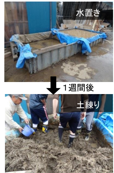
図1 壁土の練り混ぜ工程
