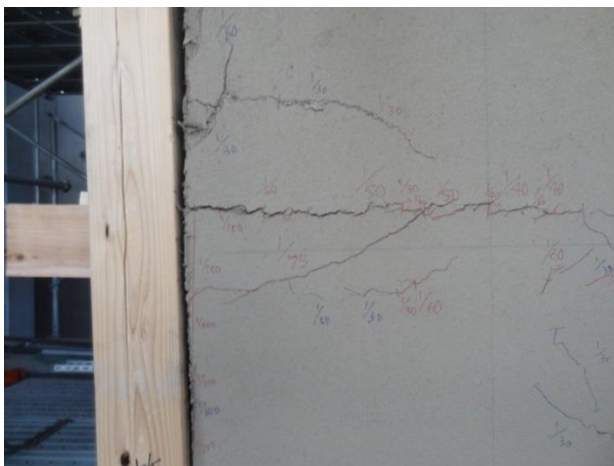
写真1 横貫に沿ったひび割れ (Type2-1 -1/30rad 時)
