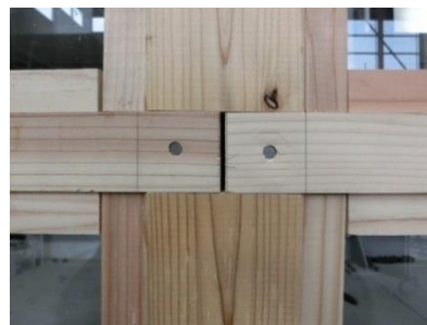
写真1 横格子材の引き抜け
