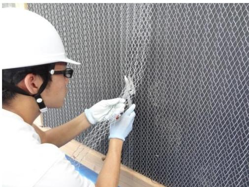
写真3 ラス網の切断
