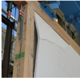
写真1 ラスボードの座屈
