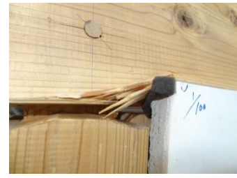
写真3 壁板の面外への剥がれ
