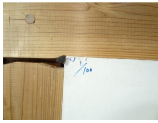
写真2 壁板のめり込み
