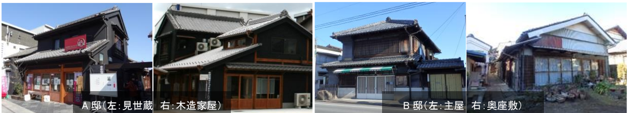
写真1 対象建造物外観
