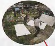
復興ドーム設営地
