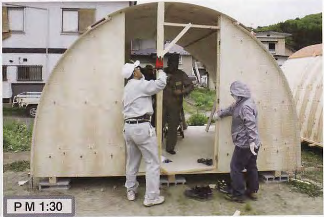
型取りした妻壁パネルをはってドア枠取り付け
