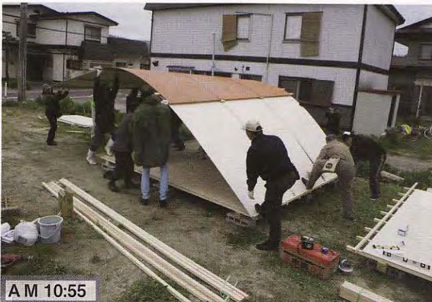
コンパネ端部を上にはりつけ保護塗料を塗って立ち上げ
