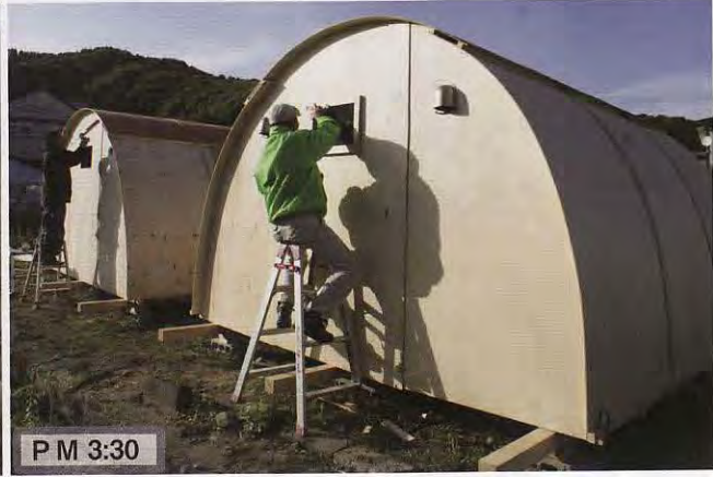
小窓をとりつけて妻壁の隙間を止水処理
