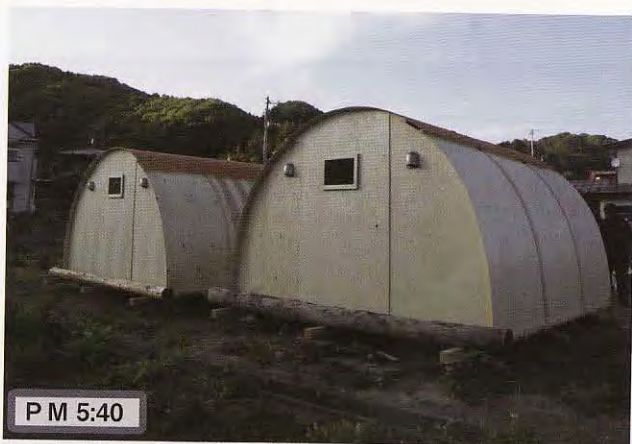
日暮れ前に完成した 換気口と流木丸太が見える
