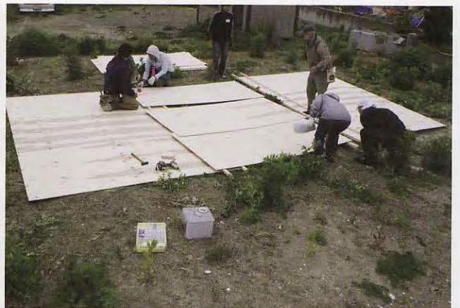
3つを合わせて角材をつなげ防水テープ処理
