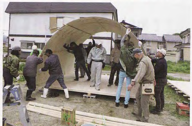
足元を固定してドーム立ち上げに成功
